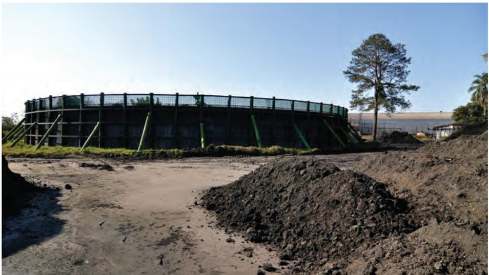
**Figura 59** Ingenio Fronterita - Filtro estático utilizado para separar las cenizas del agua de los scrubbers.
