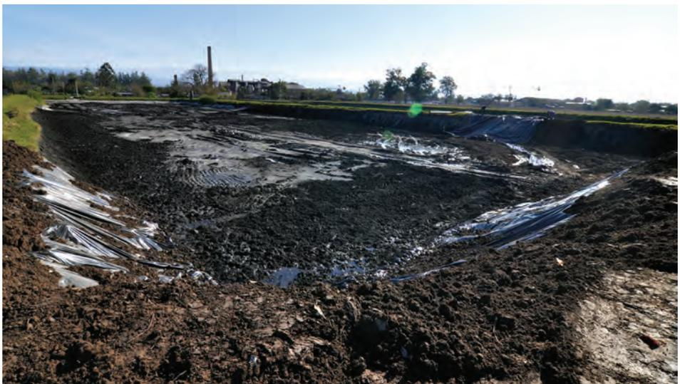
**Figura 26** Ingenio Marapa -Pileta de sedimentación de cenizas.
